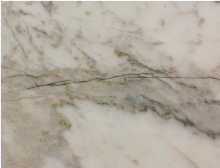
Risse und Harzfüllung.
