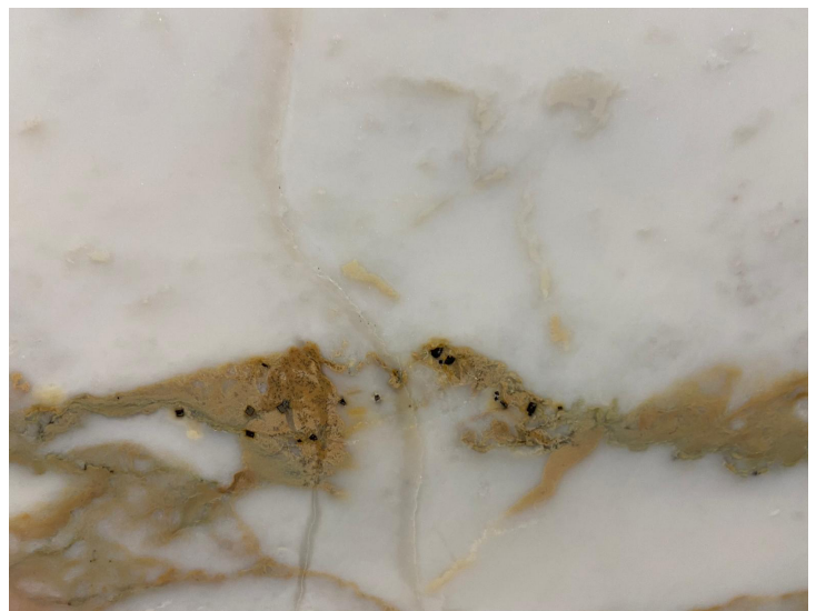
Risse und Harzfüllung.
